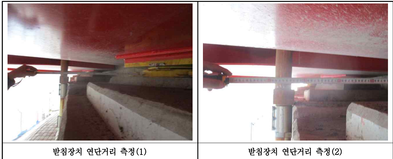
【사진 35.3.12】 교량받침장치 연단거리측정
