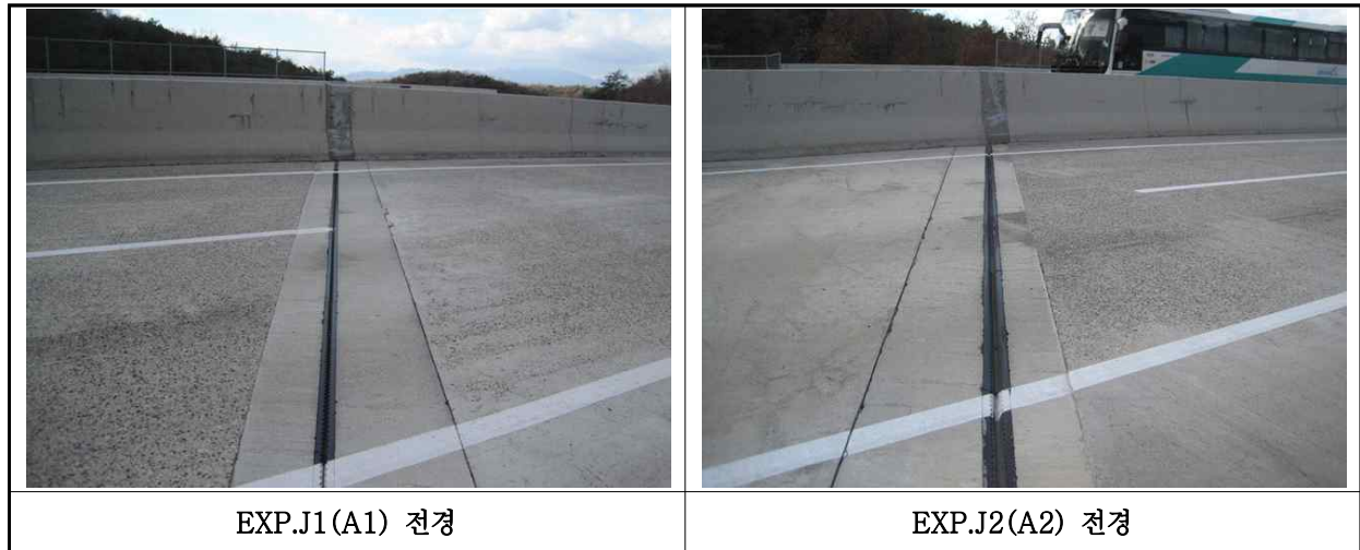
【사진 35.3.14】 신축이음장치 전경
