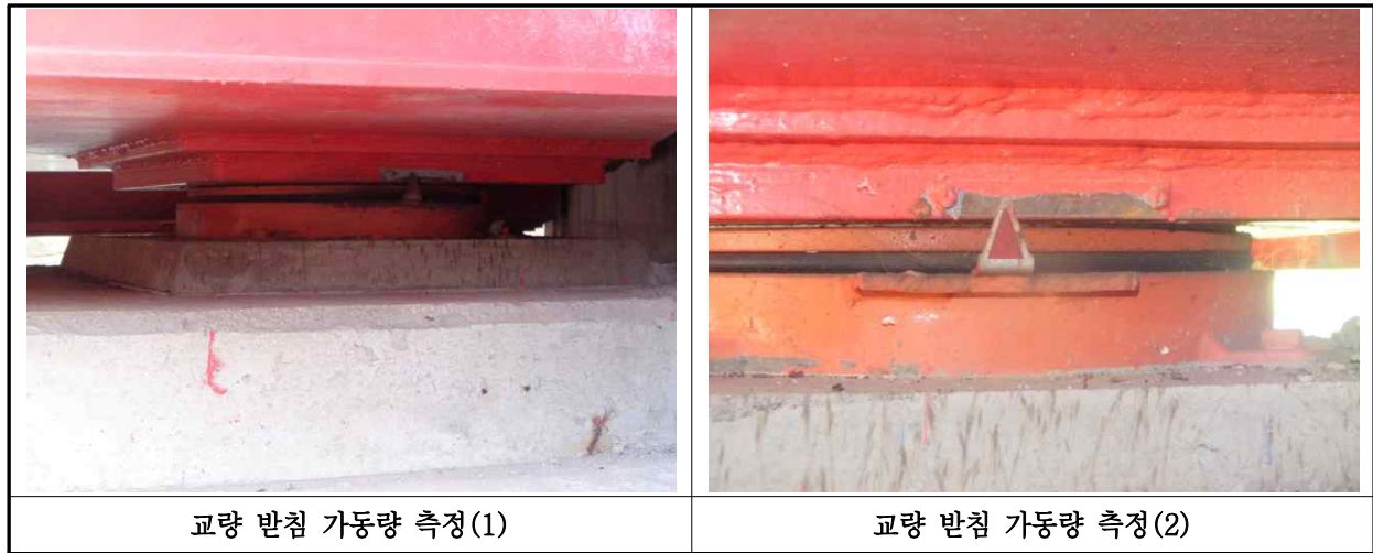
【사진 35.3.34】 교량받침 이동량 측정
