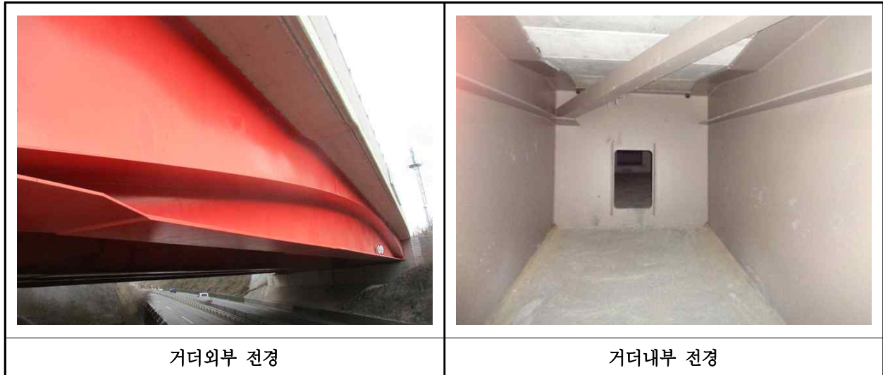
【사진 35.3.25】 거더 전경
