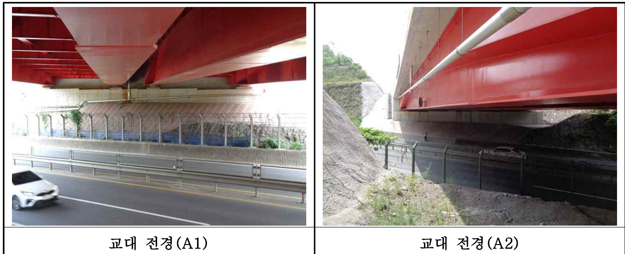
【사진 35.3.29】 교대 전경
