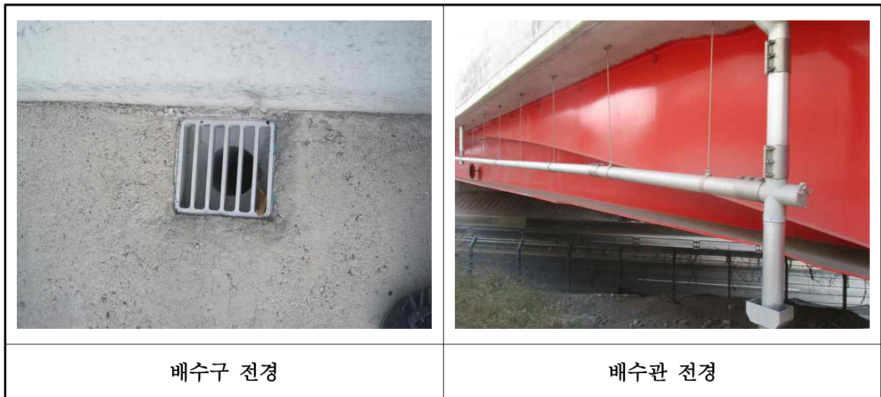
【사진 35.3.19】 배수시설 전경
