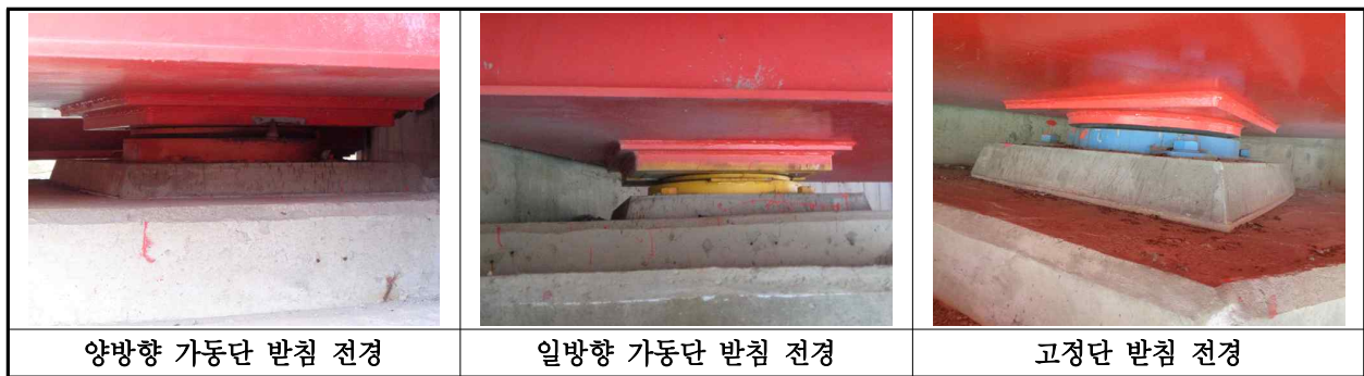
【사진 35.3.31】 교량받침 전경
