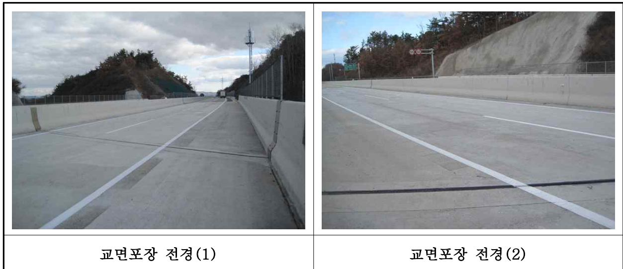
【사진 35.3.38】 교면포장 전경
