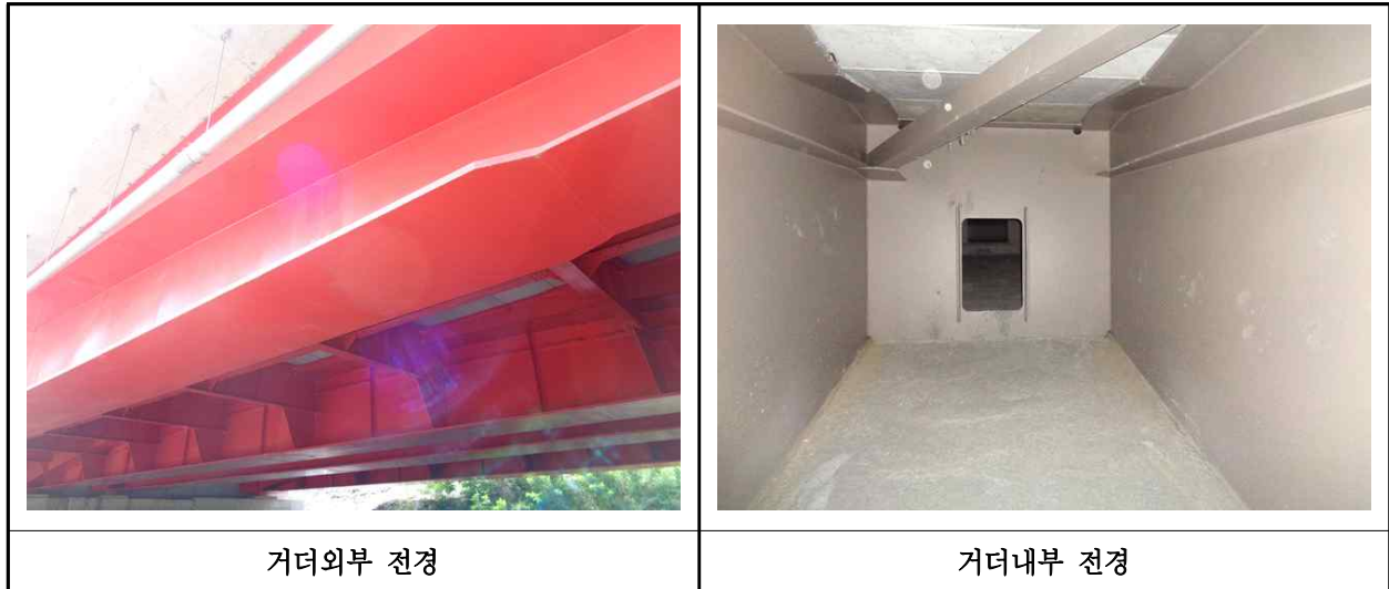
【사진 35.3.4】 거더 전경
