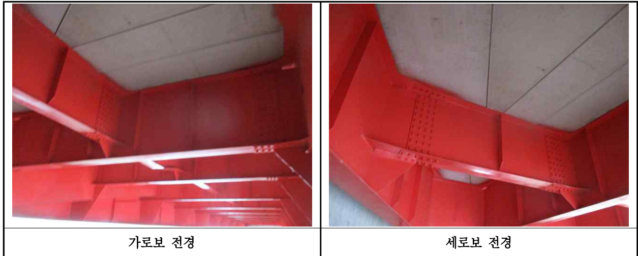
【사진 35.3.6】 가로보 및 세로보 전경
