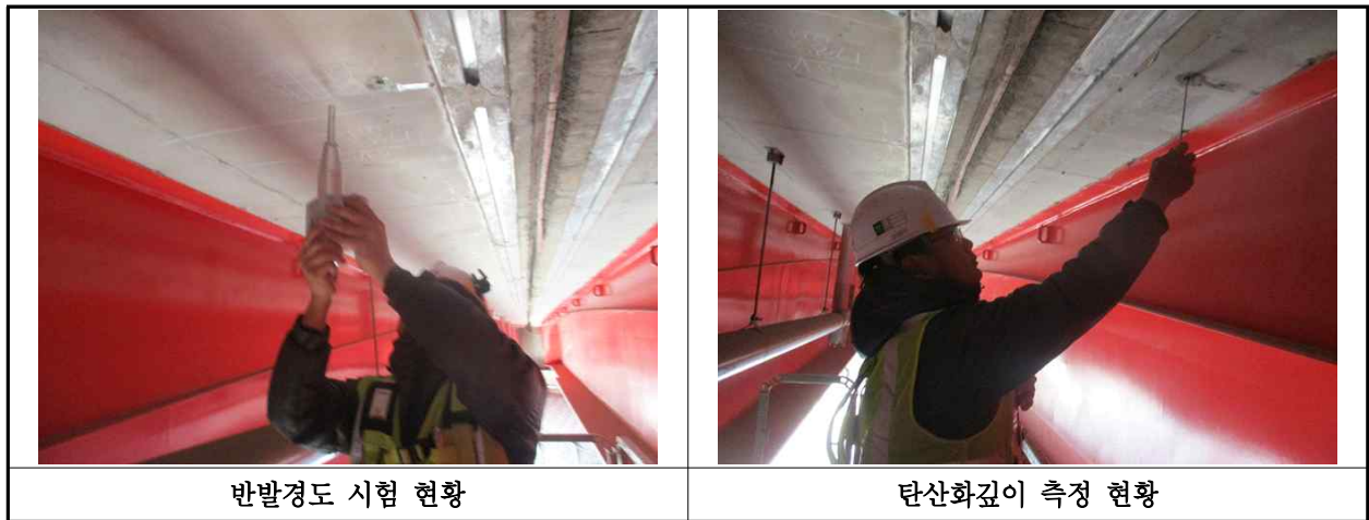
【사진 35.4.1】 콘크리트 내구성조사 현황
