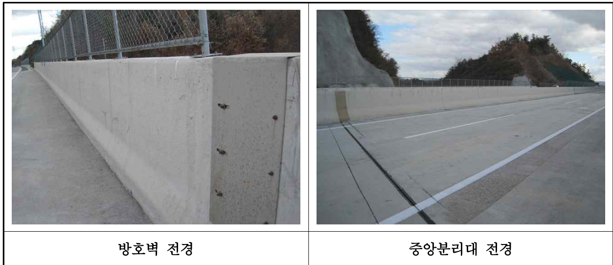
【사진 35.3.42】 방호벽 및 중앙분리대 전경
