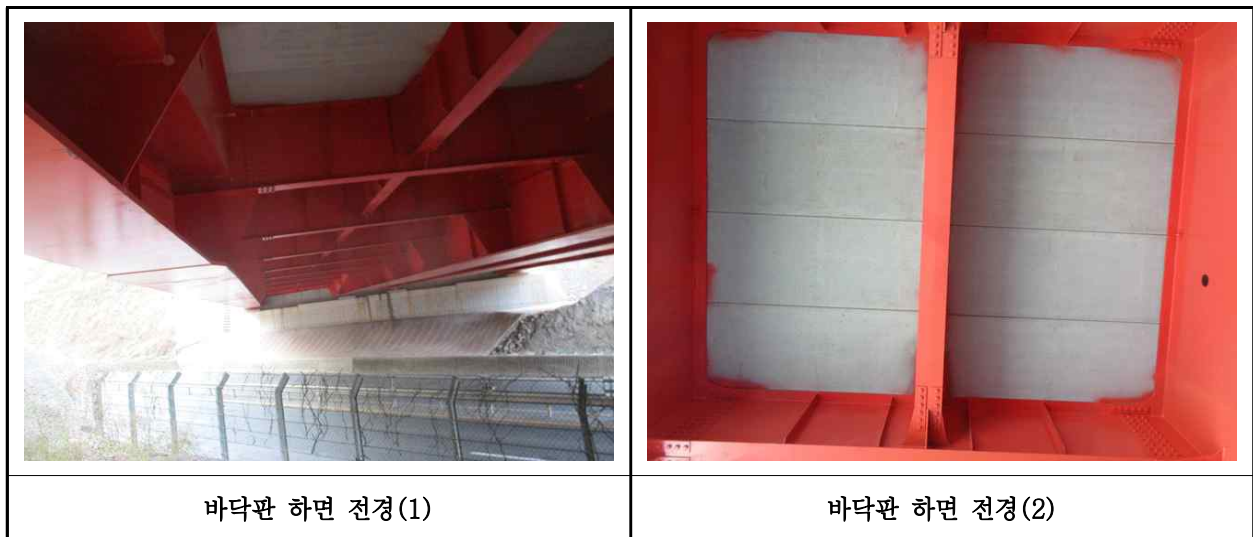
【사진 35.3.2】바닥판하면 전경
