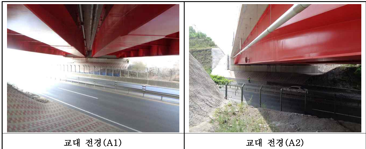
【사진 35.3.8】 교대 전경
