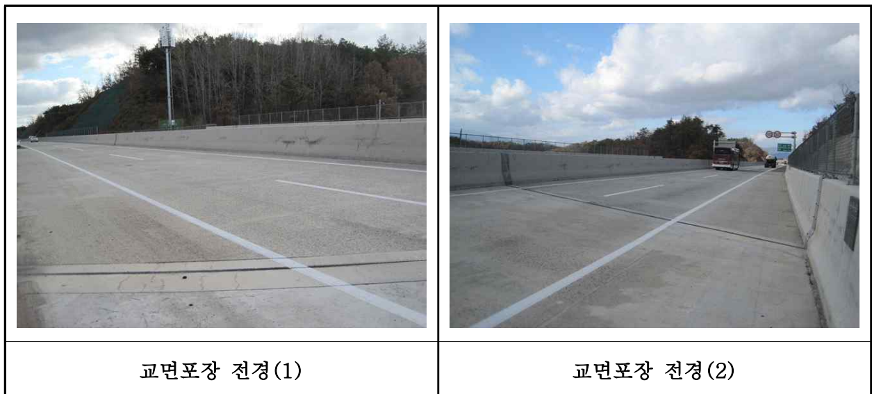
【사진 35.3.17】 교면포장 전경
