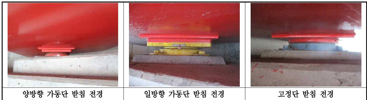
【사진 35.3.10】 교량받침 전경
