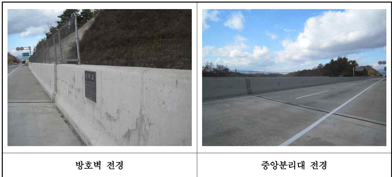
【사진 35.3.21】 방호벽 및 중앙분리대 전경
