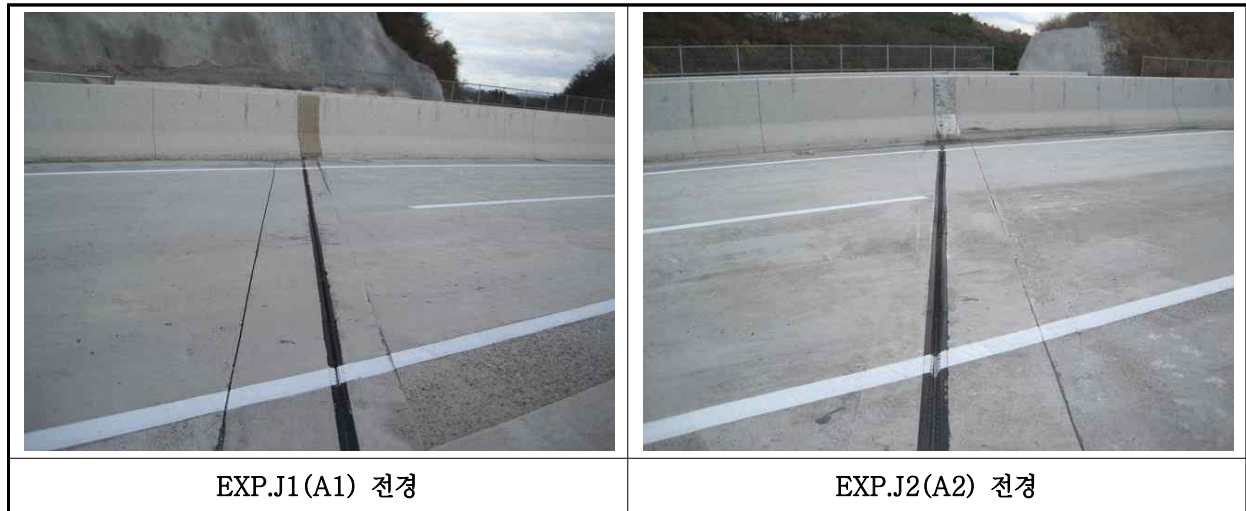
【사진 35.3.35】 신축이음장치 전경
