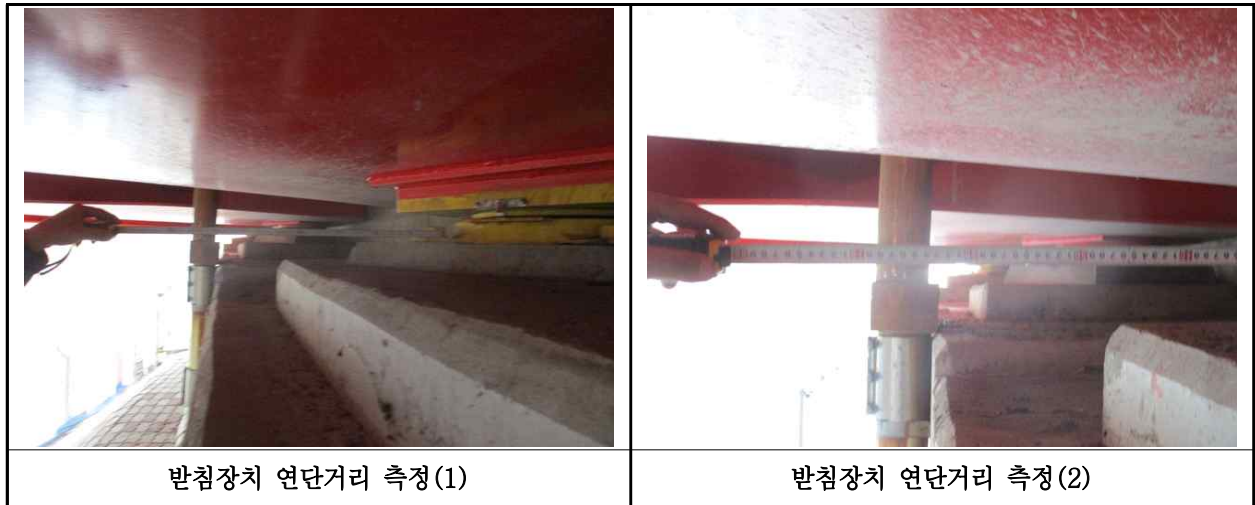
【사진 35.3.33】 교량받침장치 연단거리측정
